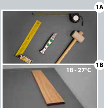
1A / Co potřebujete 1B / Před pokládáním nechte produkt aklimatizovat při pokojové teplotě na rovném podkladu po dobu minimálně 24 hodin. Doporučujeme 2-3 dny.
